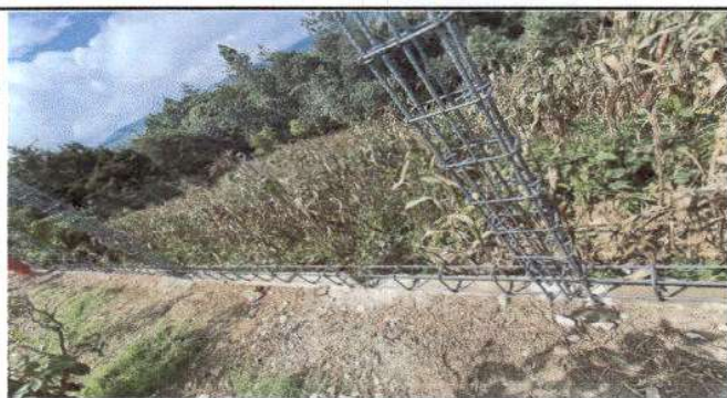
Foto 5: reparación de muro perimetral de block con columnas.
