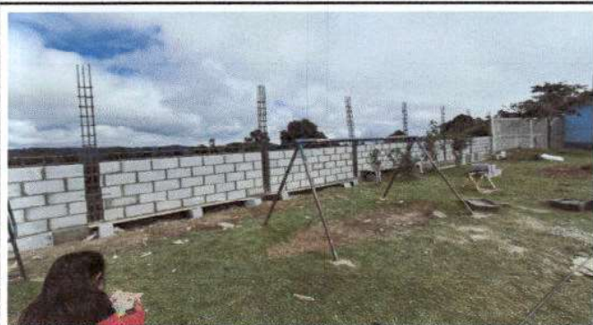
Foto 7: reparación de muro perimetral de block con columnas.
