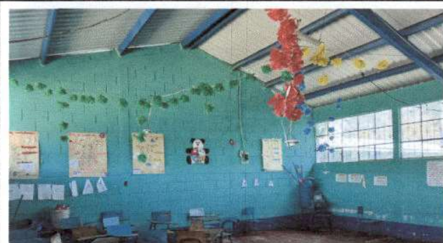
Foto 9: sustitucion de focos ahorradores modulos de aulas.
