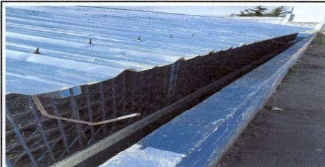
Foto 8: sustitucion de canales de pvc. Modulo 3 de aulas
