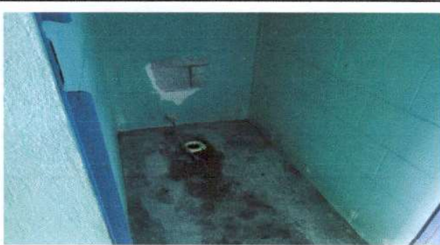
Foto 4: sustitucion de inodoros modulo de baños.
