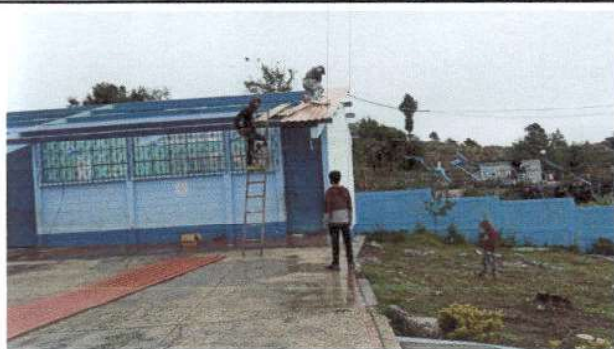
FOTO 1. Sustitucion de lámina, por lámina troquelada calibre 26, sustitucion de capote de lámina para lámina troquelada, sustitución de elementos de fijación. Modulo 1 de aulas.
