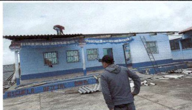
Foto 2: Sustitucion de lámina, por lámina troquelada calibre 26, sustitucion de capote de lámina para lámina troquelada, sustitución de elementos de fijación. Modulo 2 de aulas.
